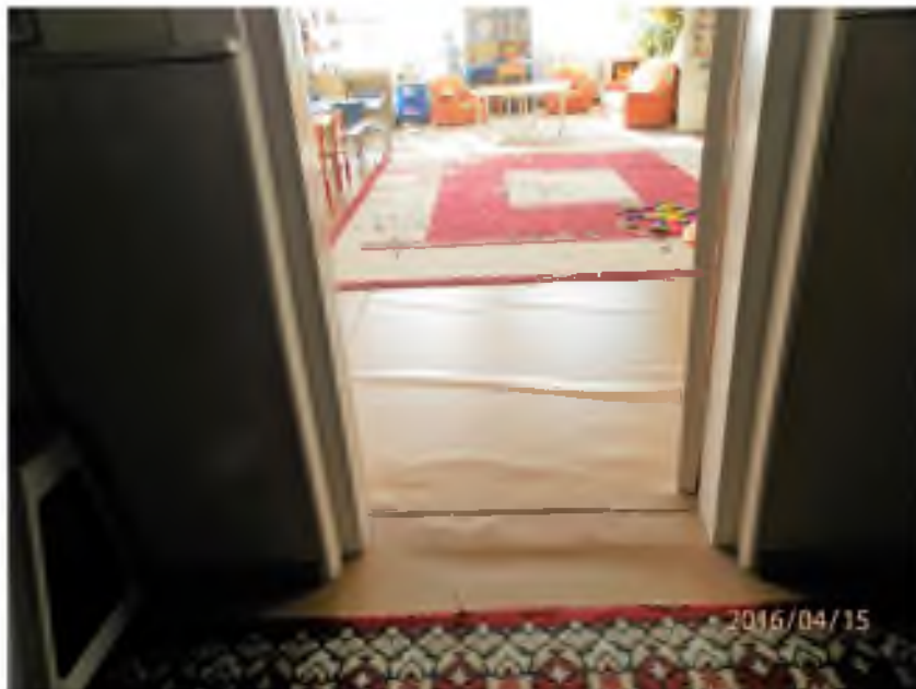
Фото 11 Локальная деформация финишного покрытия пола.
