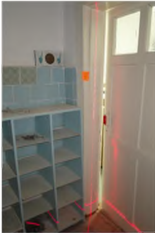
Фото13 Отклонение от вертикали до 40 мм внутренней стены , нарушение геометрии дверного проема.
